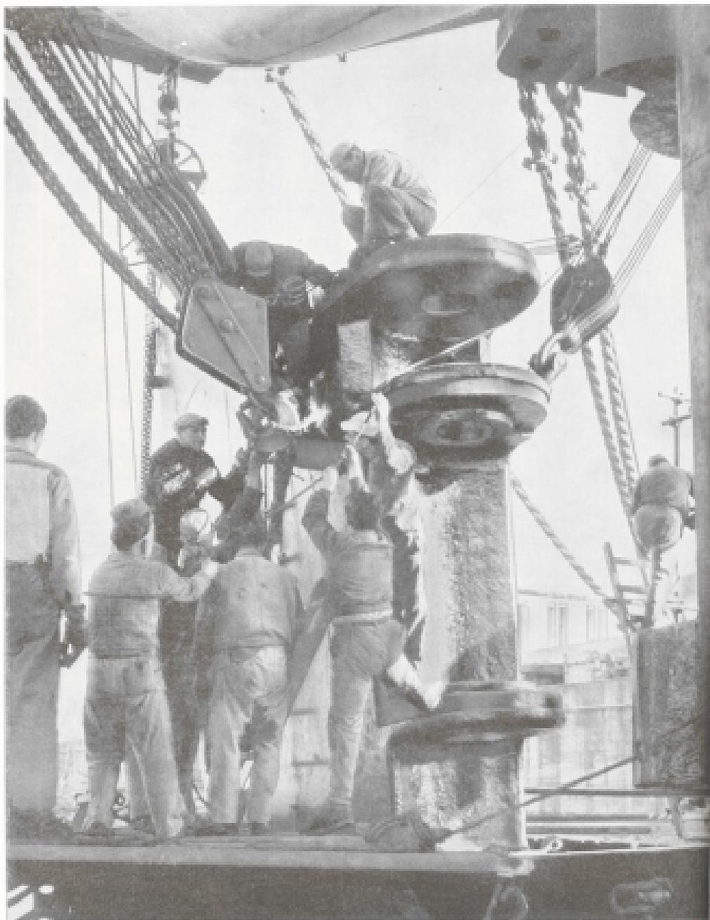
Montaggio del timone della supercavitazione « Agrigento » in allineamento al cantiere di Sestri
